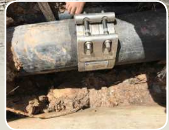
▲ PE Pipe Repair
